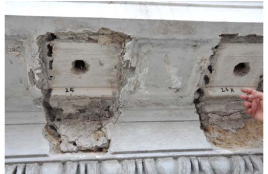
IV. Rimozione e catalogazione modiglioni
